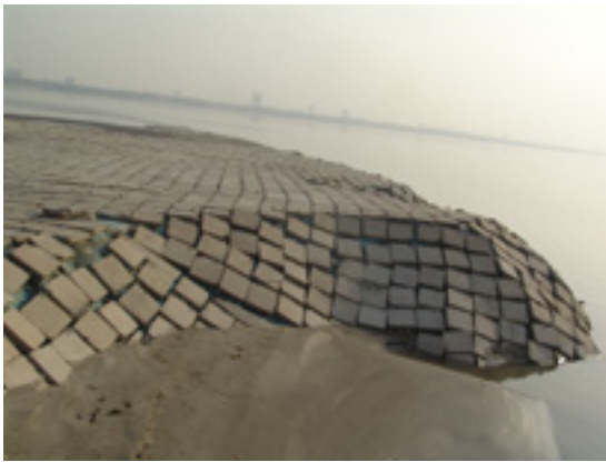
原型护滩带边缘排体悬挂照片
