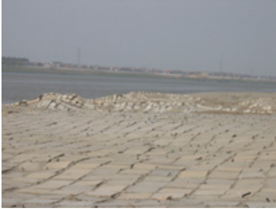
原型护滩带中部鼓包照片
