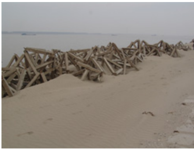
东流水道透水框架现场试验 2 个水文年后效果
