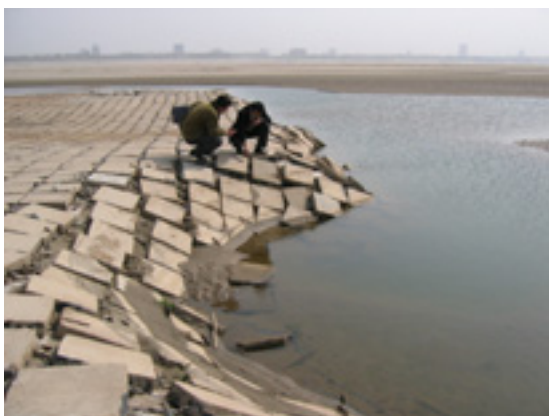
原型护滩带边缘塌陷照片
