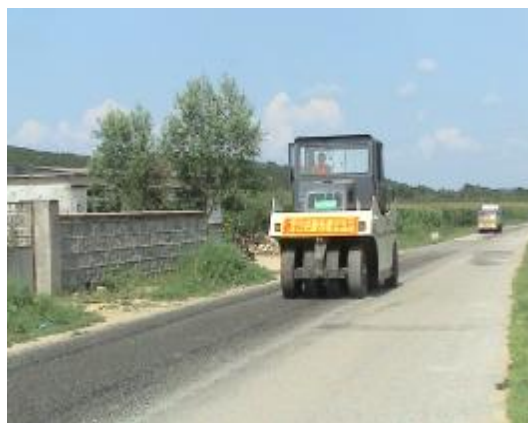
图 24 同步碎石封层碾压
