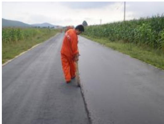
图 30 接缝处理
