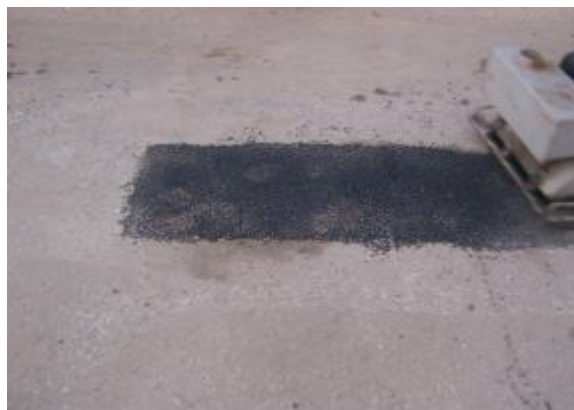
图 21 坑槽压实
