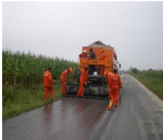
图 28 稀浆封层施工
