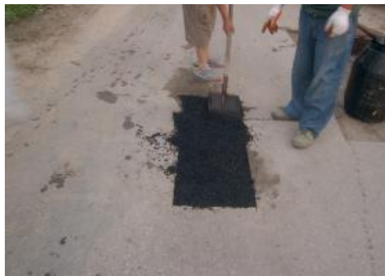
图 20 摊铺沥青混合料
