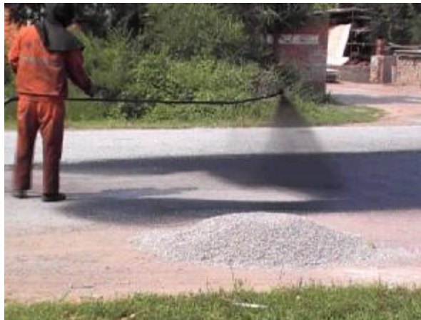
图 36 喷洒第一层沥青
