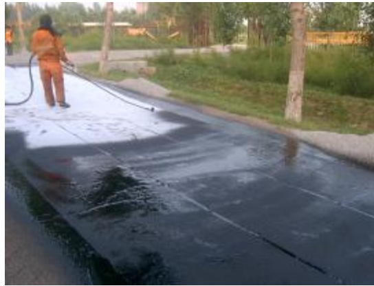
图 38 喷洒第二层沥青
