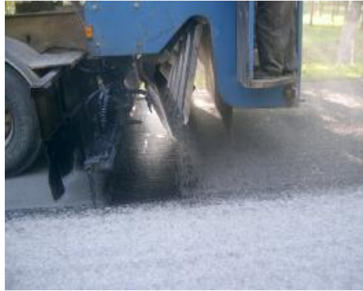
图 23 同步碎石封层车施工
