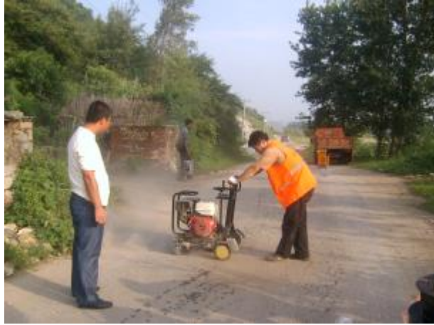
图 17 坑槽切割和开挖
