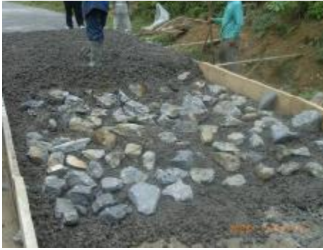
图 3.1-13 片石混凝土示范路施工
