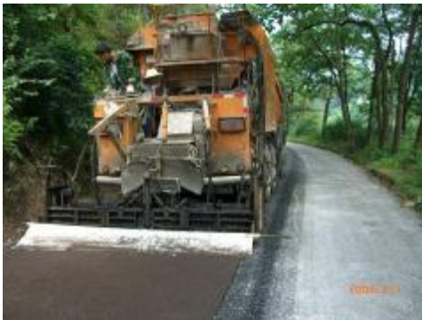
图 3.1-11 新型薄型沥青路面摊铺中
