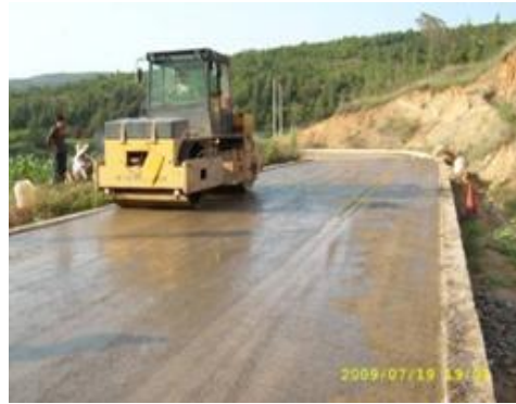
图 3.1-10 碾压混凝土路面施工中
