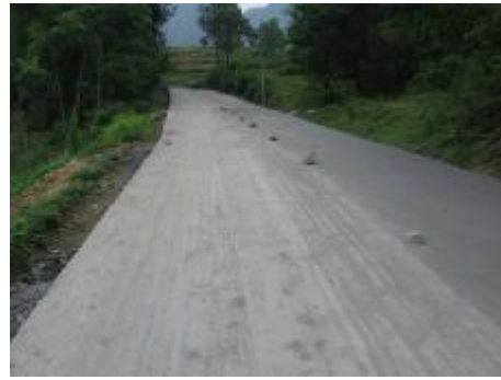
图 3.1-14 成型后的片石混凝土路面
