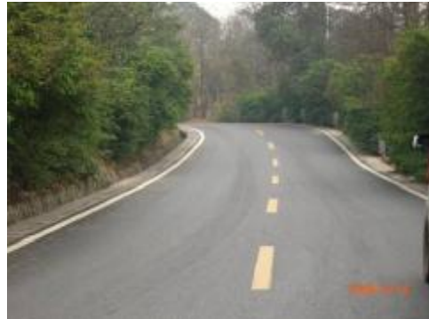
图 3.1-12 摊铺成型新型薄型沥青路面
