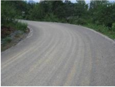
图 3.1-7 固化剂基层效果
