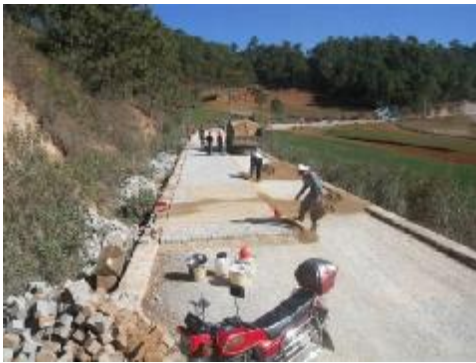
图 3.1-9 整齐块体弹石路面施工中
